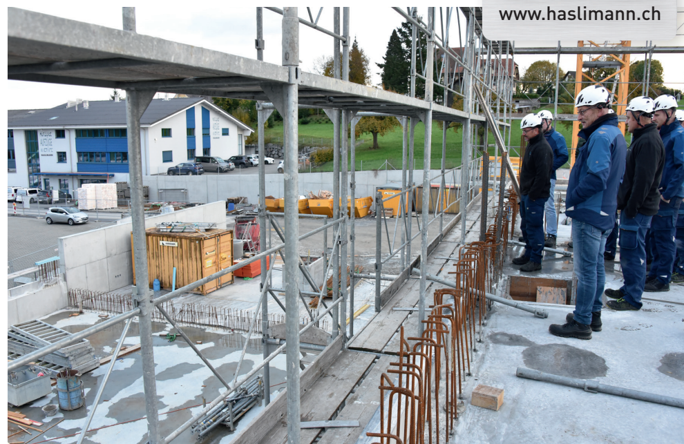
Blick vom 1. Obergeschoss in die zukünftige Schlosserei und zum bestehenden Firmengebäude.
